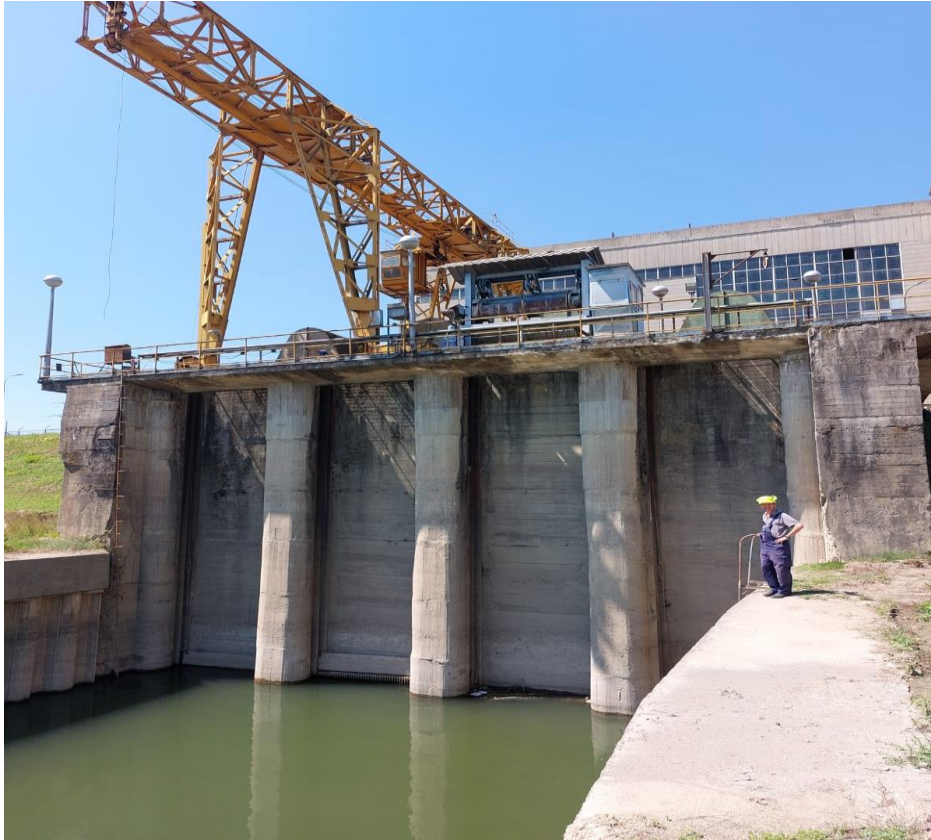
Sl. 4. Crpna stanica na vodozahvatu rijeke Save
