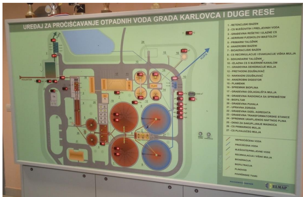
Slika 4. Kontrolna ploča UPOV Karlovac za prćenje trenutnih faza pročišćavanje otpadne vode.
