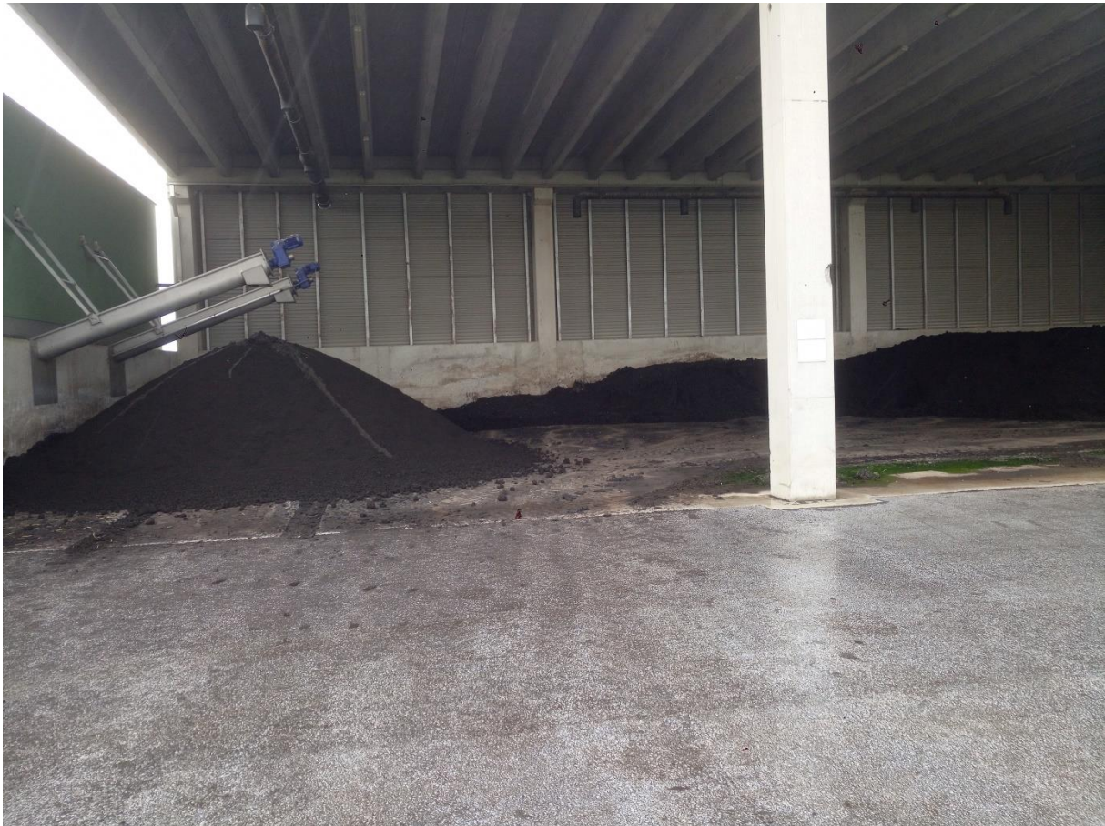
Slika 6. Dehidrirani mulj UPOV Karlovac.
