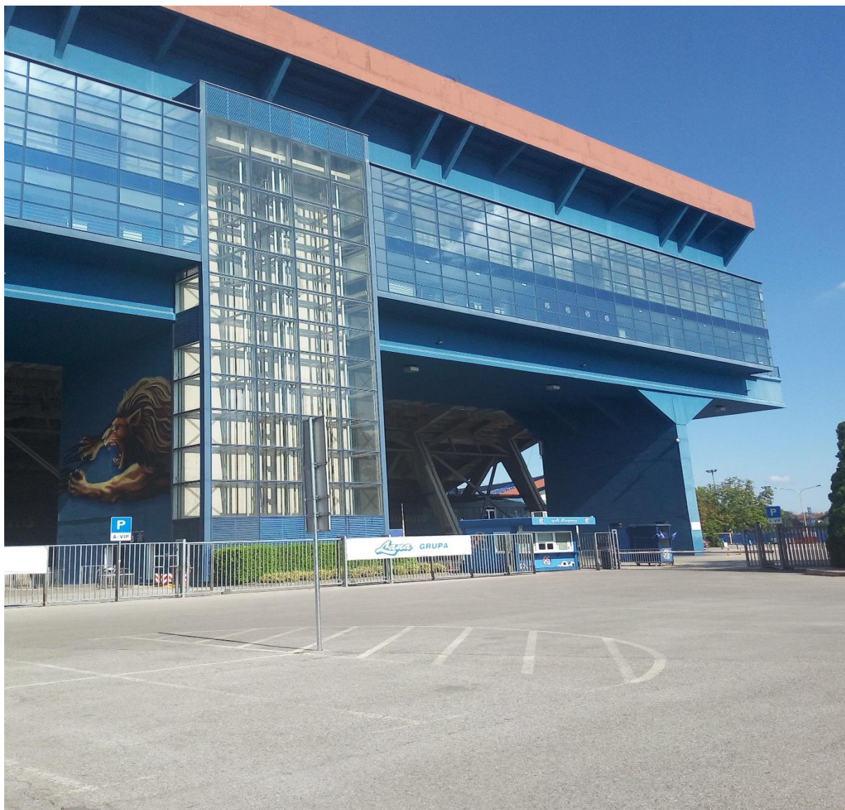
Sl.3. Izgled Stadiona Maksimir izvana
