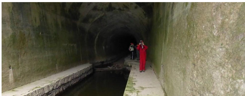
Slika 2. Prikaz hidrotunela iznutra.
