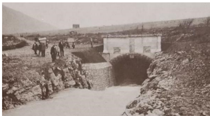
Slika 1. Na slici je prikazan početak protoka jezerske vode prema zaljevu kroz hidrotunel.
