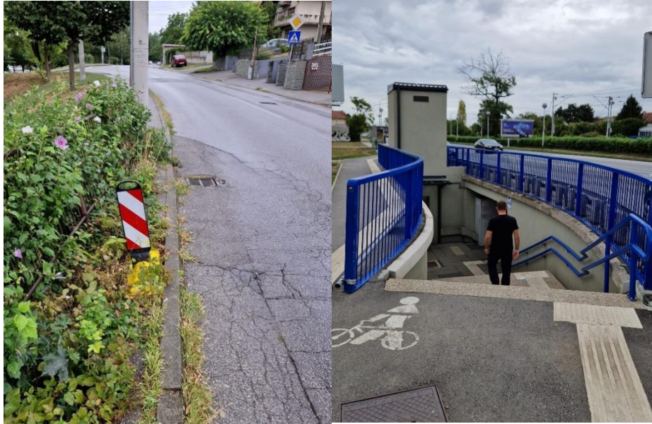
Sl. 6. i 7. Suženje nogostupa u ulici Karažnik i novouređeni pothodnik na raskrižju Aleje Bologne i Gospodske ulice
