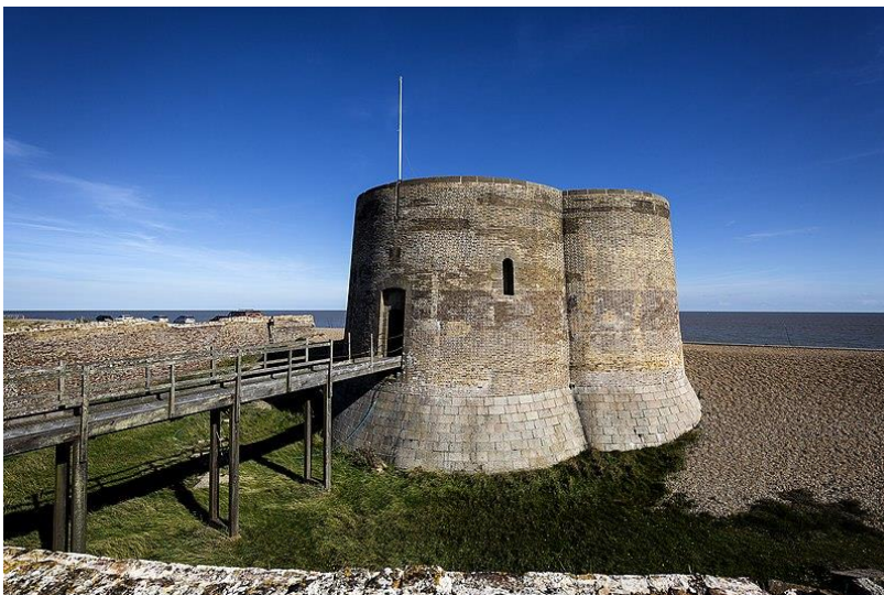
Slika 2. Obrambene kule, Maetello Towers
