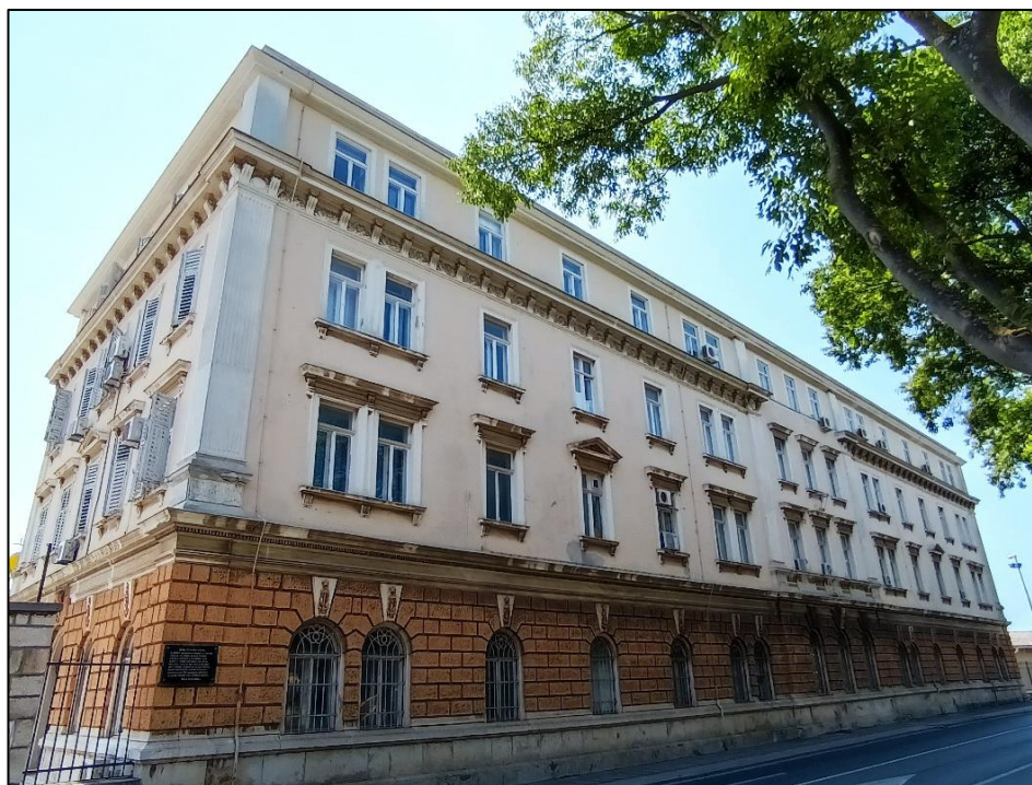
Sl.13.: Upravna zgrada Brodogradilišta „Uljanik“, snimljena s Flaciusove ulice – građevinski objekt pripada kategoriji „1“ valorizacije građevinskog nasljeđa - Izvor: snimio autor 18. srpnja 2022.
