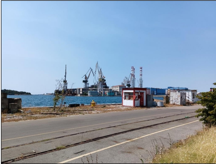
Sl.14.: Dionica industrijskog željezničkog kolosijeka koji povezuje željeznički kolodvor u Puli s brodogradilištem Uljanik Izvor: snimio autor 18. srpnja 2022.
