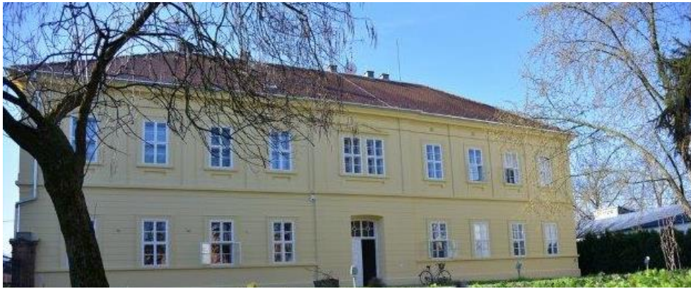
Sl. 13: Zgrada iz vremena Austrougarske, današnja Knjižnica i Radio Županja
