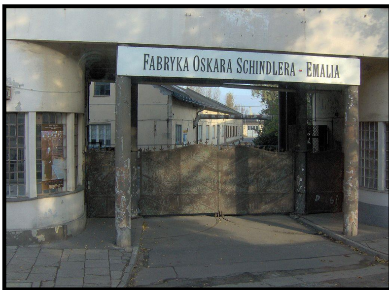
Sl. 20. Tvornica emajla Oskara Schindlera
