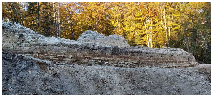
Slika 8: Ostaci srednjovjekovne trokutaste kule Krčingrad sa zidinama, izgrađeni od sedre.
