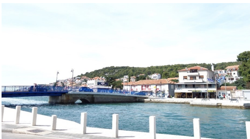
Slika 2. Most u Tisnom koji povezuje kopno s otokom Murterom
