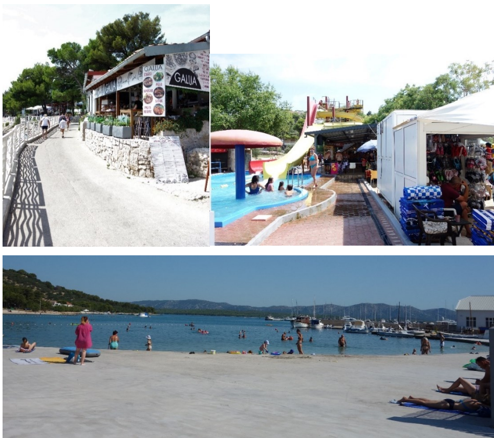
Slike 25., 26. i 27. Betonirane plaže i neadekvatno izgrađeni ugostiteljski objekti i rekreacijski platoi
