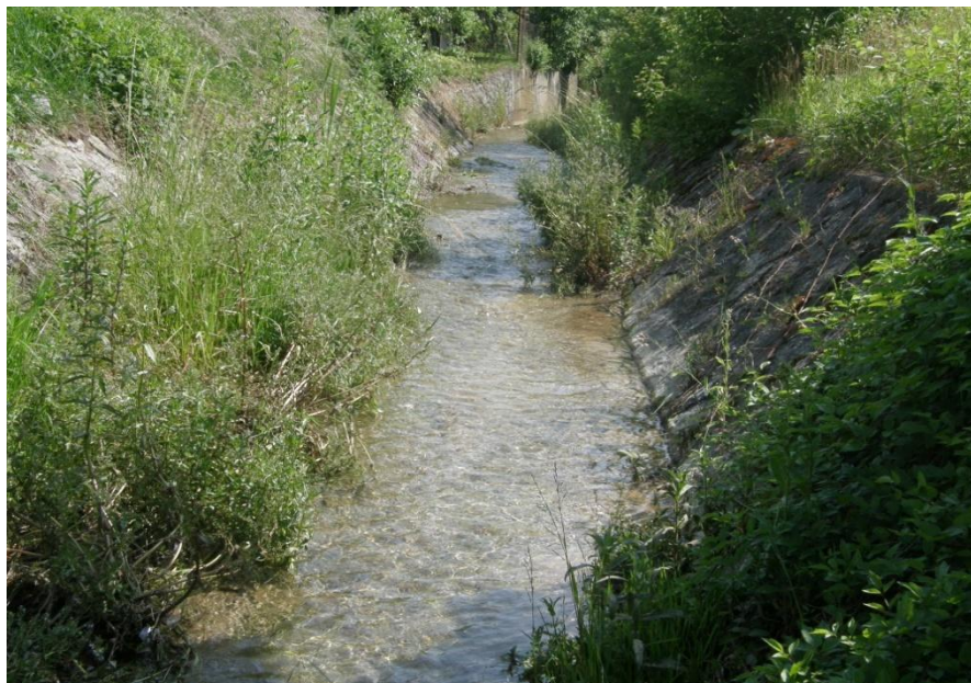
Slika 7. Izgled lokaliteta 2 (kanal)
