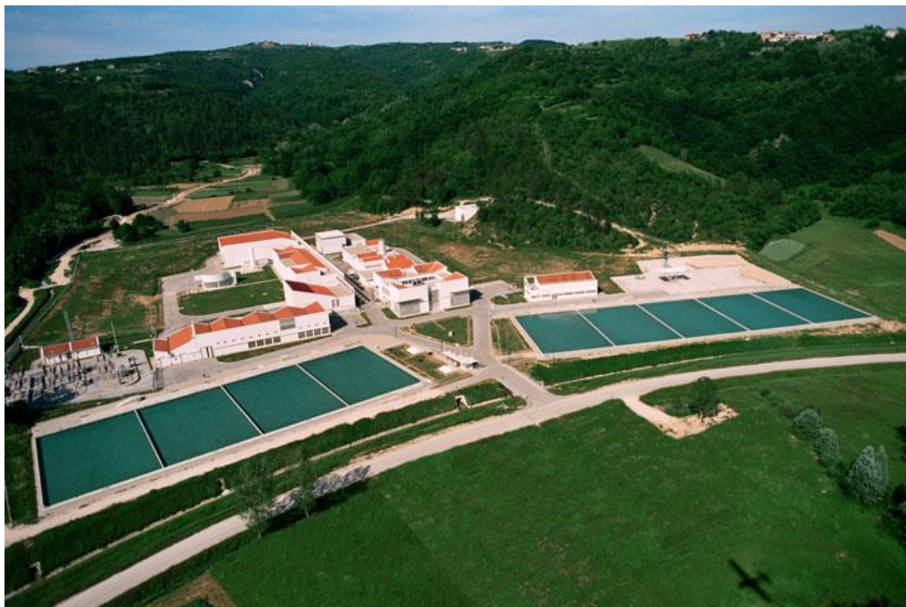
Slika 4. Pogled na postrojenje za kondicioniranje vode ( www.beta.ivb.hr ).
