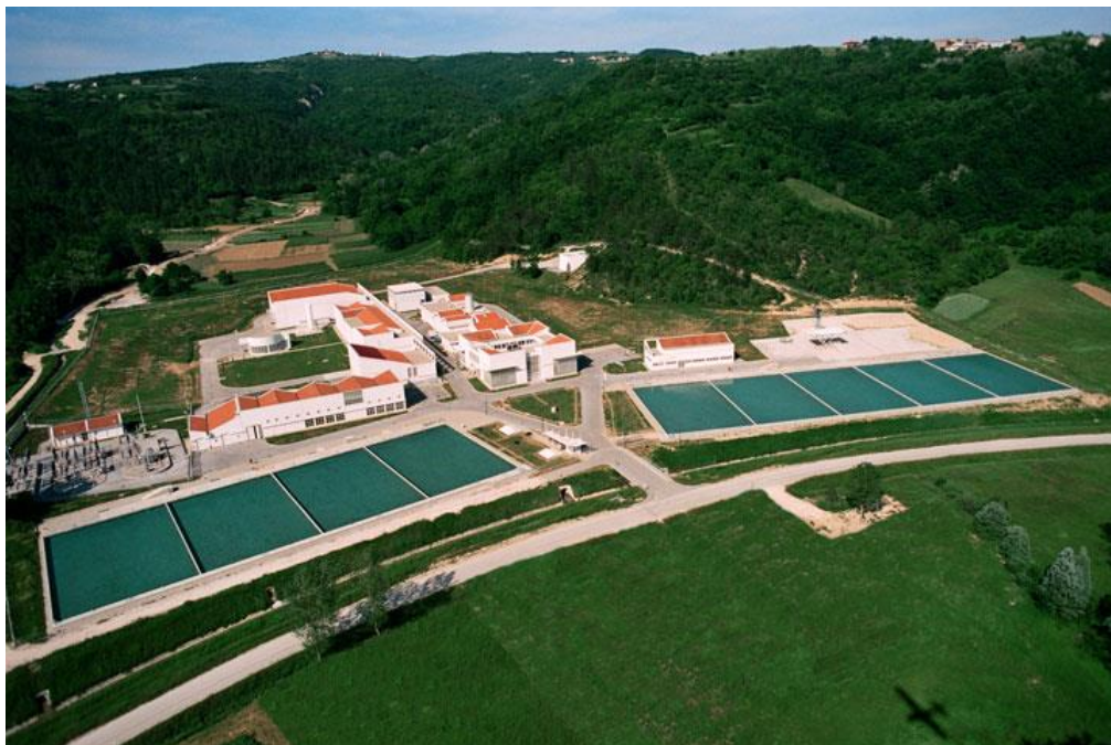
Slika 4. Pogled na postrojenje za kondicioniranje vode ( www.beta.ivb.hr ).
