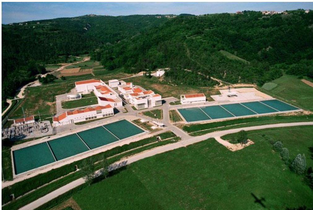
Slika 4. Pogled na postrojenje za kondicioniranje vode ( www.beta.ivb.hr ).
