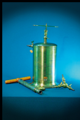
Uzdušno stiskalo od 10 litara k tomu: puhaljka 108a, kugla od mjedi provođena pipcima 31. 5. 1876.
