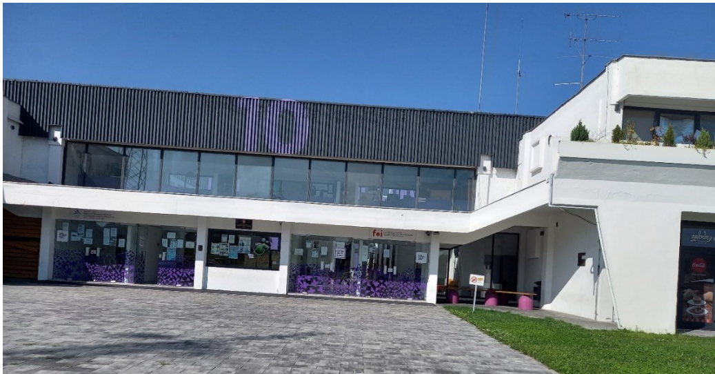
Sl. 33. Zgrada Pučkog otvorenog učilišta u Zaboku 2023. godine
