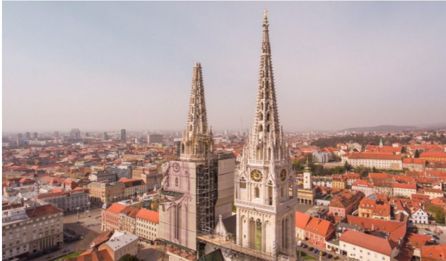
Slika 2.8: Oštećenje južnog tornja Zagrebačke katedrale u potresu koji je pogodio Zagreb 22. ožujka 2020. godine u 6 sati i 24 minute po lokalnom vremenu. (izvor: Detaljno izvješće o oštećenjima Zagrebačke katedrale , katedrala.hr)
