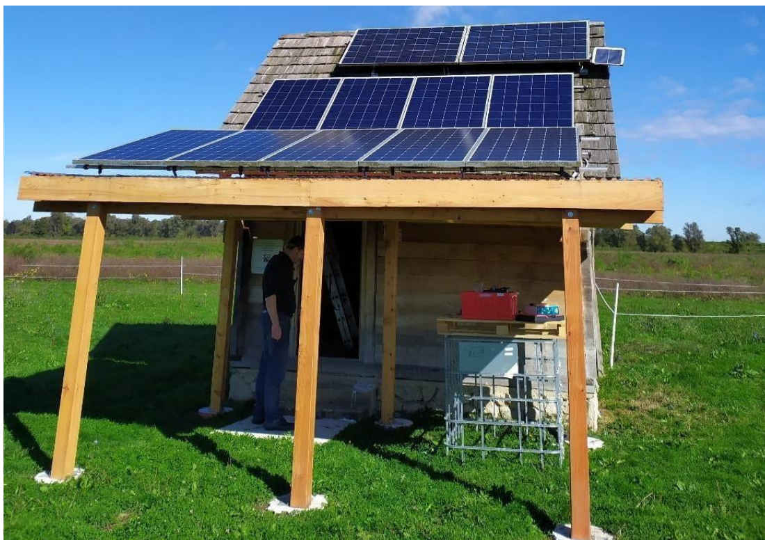
Slika 1.3 – Solarni paneli na krovu kontrolne kuće.
