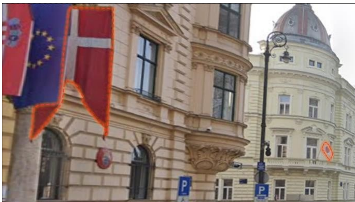
Slika 2. Dansko (prva zgrada u nizu) i japansko (druga zgrada u nizu) veleposlanstvo u Zagrebu, izvor: Google Maps, 2023
