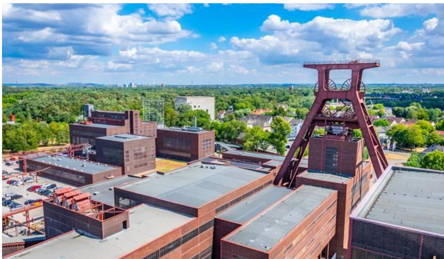
Sl. 13 Pogled na nadzemne objekte Zollverein
