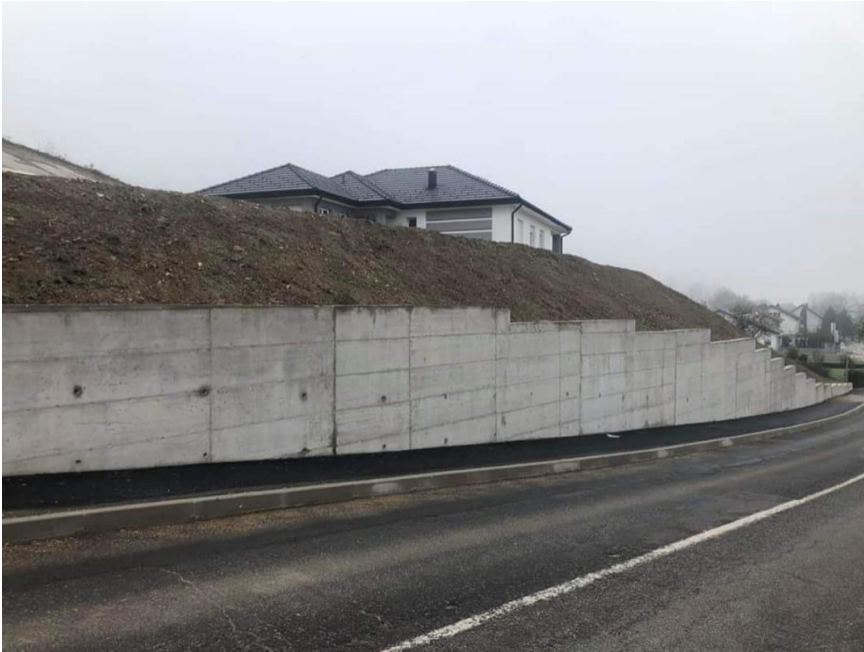
Sl.19. Završena izgradnja armirane škarpe za zaštitu aktiviranog klizišta u Krapinskim Toplicama
