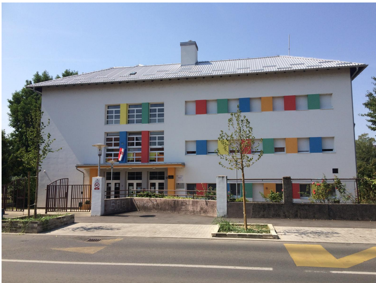
Sl. 14. OŠ Frana Krste Frankopana (fotografirano 16. 8. 2024.)
