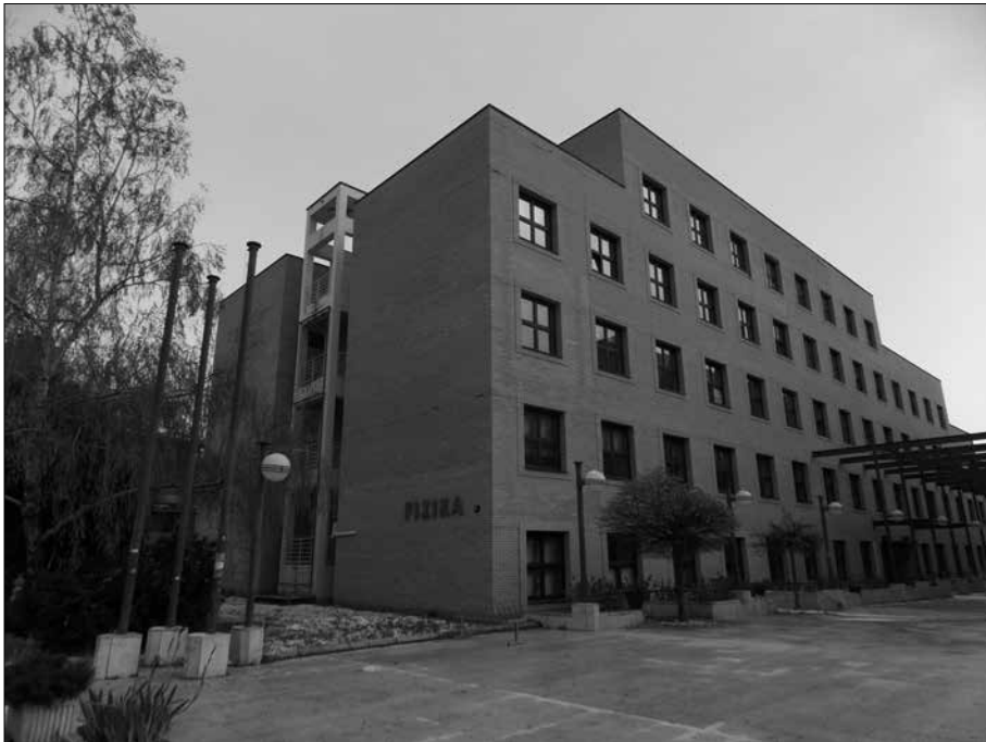
Slika 3. Zgrada Fizike, Bijenička 32
