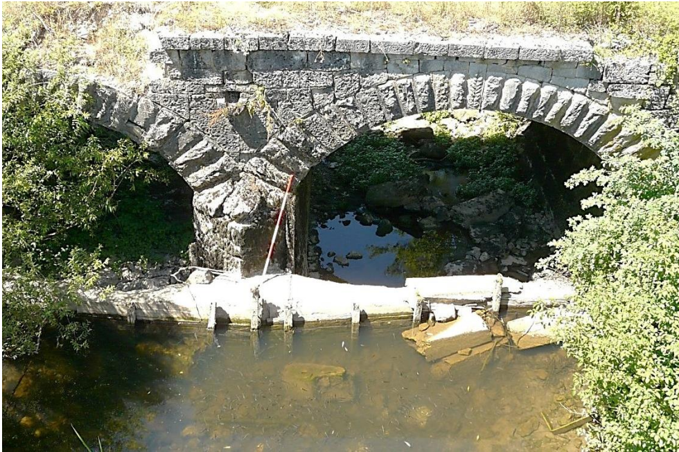
Slika 3.8. Pregrada na potoku Sušik
