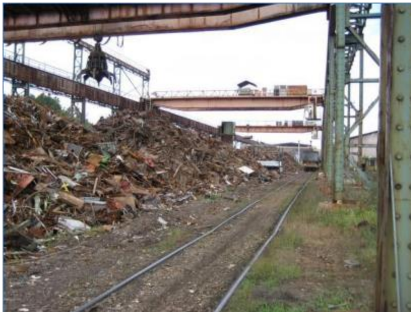
Slika 4. Čelični otpad odložen na nezaštićenoj površini deponija tvornice čelika Sisak (izvor: Sofilić i sur., 2013)
