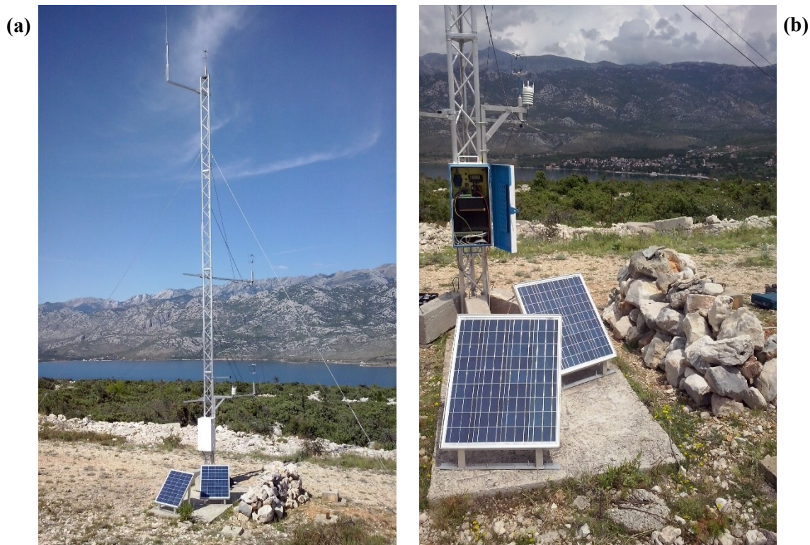
Slika 3.3. Prikaz meteorološkog stupa. a) Ultrasonični anemometri postavljeni na visinama 2, 5 i 10 m. Dodatno, senzor za temperaturu, relativnu vlažnosti i tlak postavljeni su na nivou od 2 m. b) Prikaz baze meteorološkog stupa sa solarnim napajanjem u prvom planu. Prednja solarna ploča postavljena je u smjeru jugozapada, a stražnja u smjeru jugoistoka.
