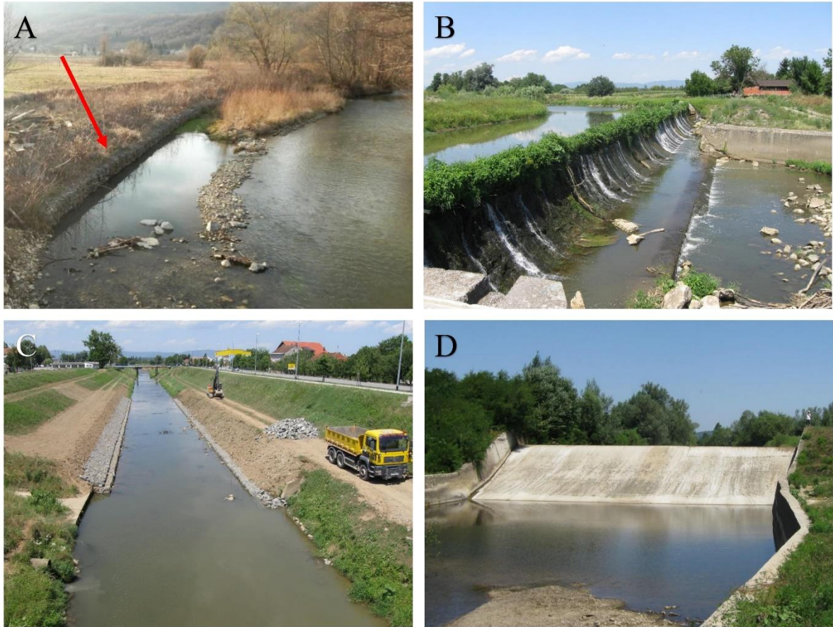
Sl. 2.9. Ljudski utjecaji na morfologiju korita: A) obaloutvrda od kamenog nabačaja, B) stepenica u Pleternici, C) kanalizirano korito u Pleternici, D) stepenica nizvodno od Bečiča
