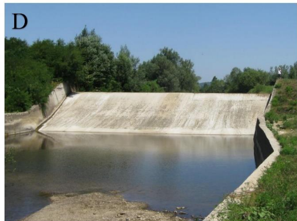
Sl. 2.9. Ljudski utjecaji na morfologiju korita: A) obaloutvrda od kamenog nabačaja, B) stepenica u Pleternici, C) kanalizirano korito u Pleternici, D) stepenica nizvodno od Bečiča
