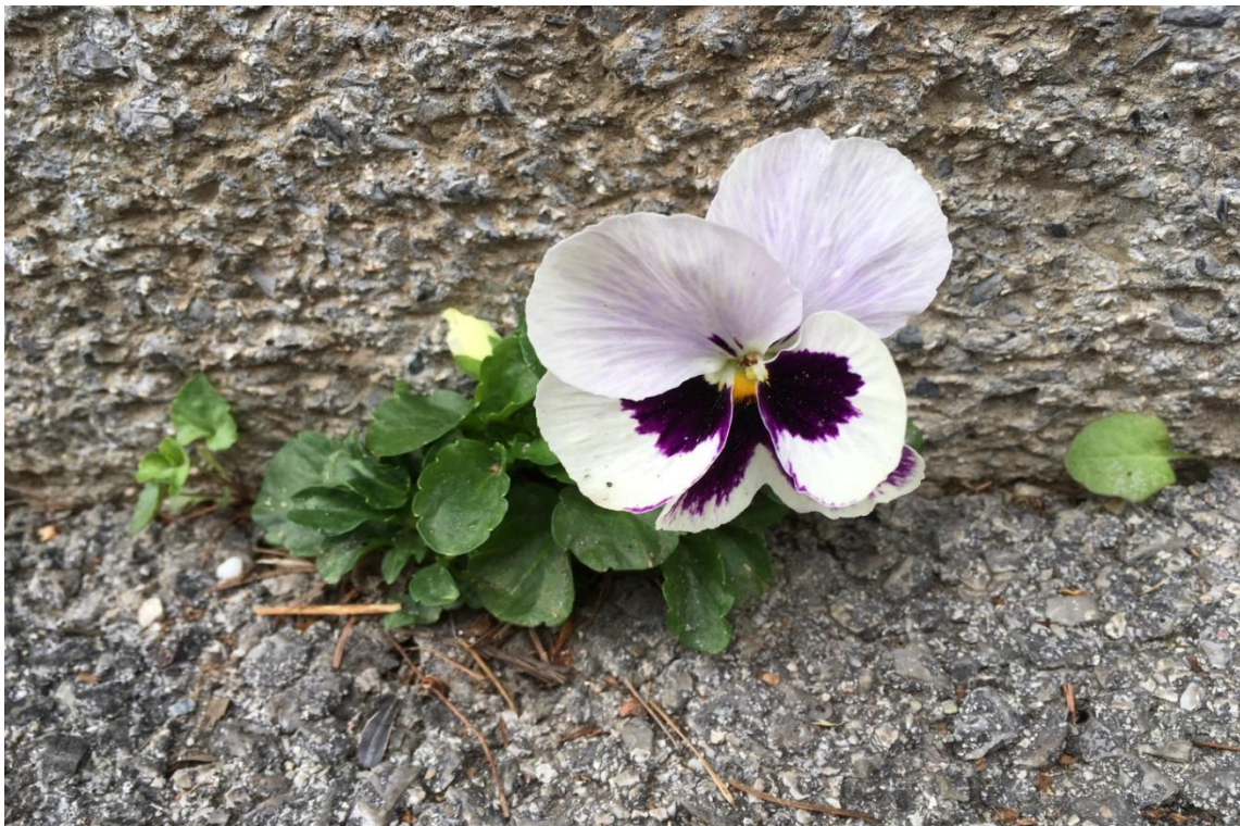
Slika 48. Viola x witrockiana pronađena u pukotini asfalta
