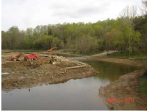
Slika 3 Suha drenaža na jezeru Needwood (USA) (Preuzeto sa www.untamedscience.com )
