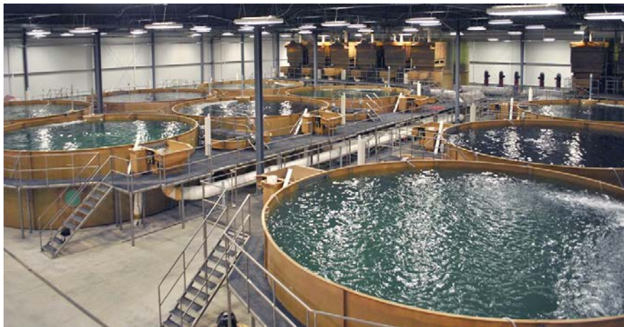
Slika 5. Zatvoreni recirkulacijski sustav ( www.italy-croatia.eu )
