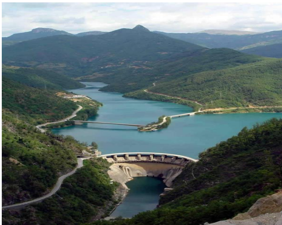
Sl. 26. HE Jablanica – prvo i najveće hidroenergetsko postrojenje na rijeci Neretvi, izgrađena 1955. godine
