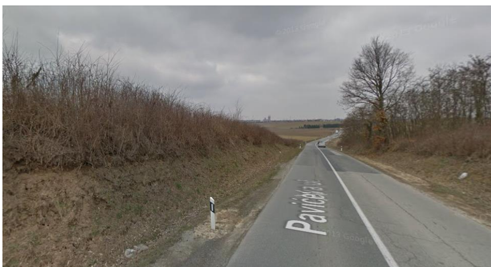
Sl. 8. Dinamičniji reljef na cesti između naselja Budrovci i Đakovo. Pogled prema Đakovu.
