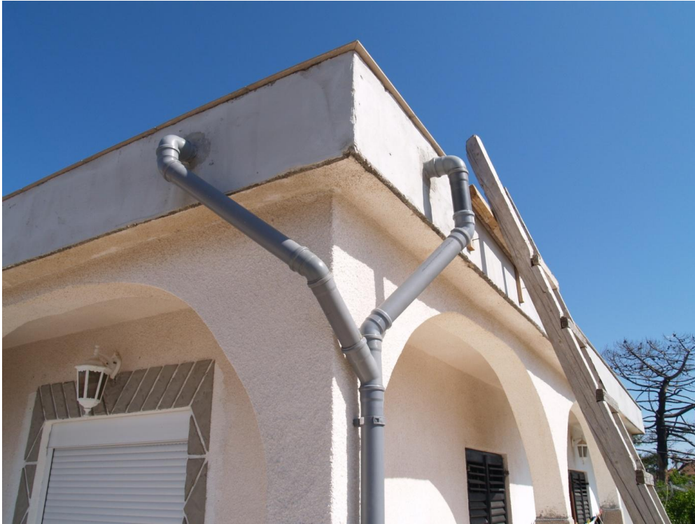
Slika 8. Postavljeni drenažni sustav
