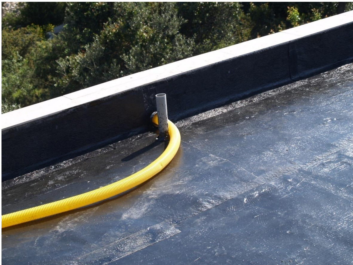
Slika 10. Detaljni pogled na drenažnu cijev
