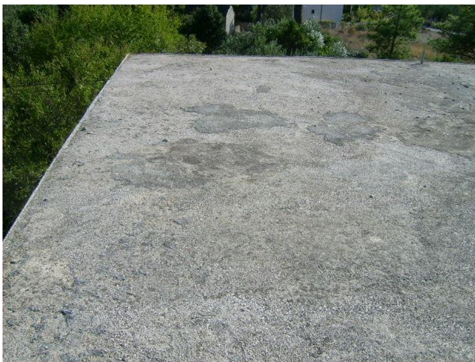
Slika 6. Dio očišćenog krova
