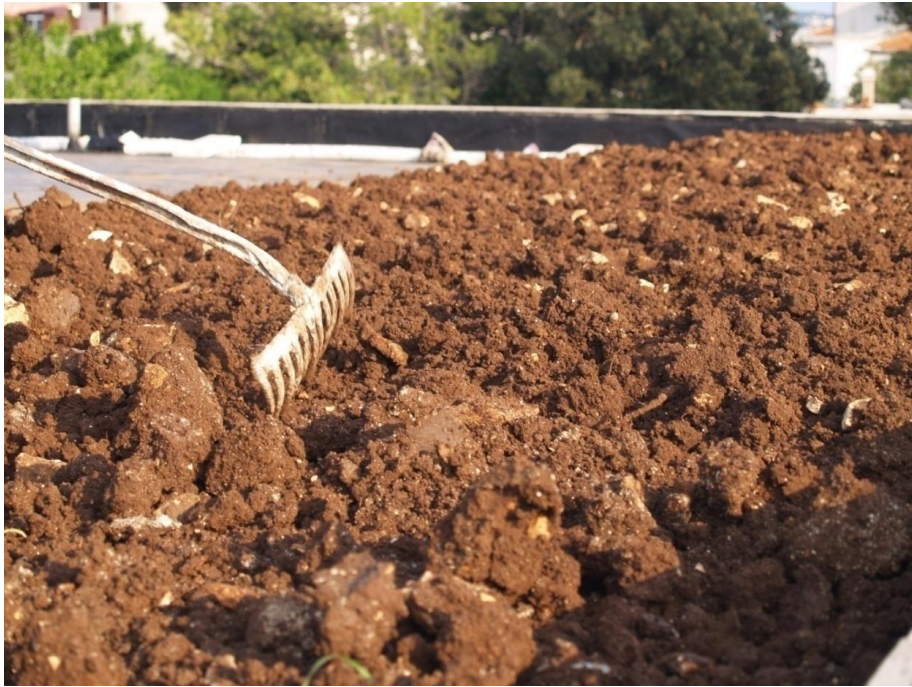
Slika 11. Raspoređivanje supstrata na drenažnoj podlozi
