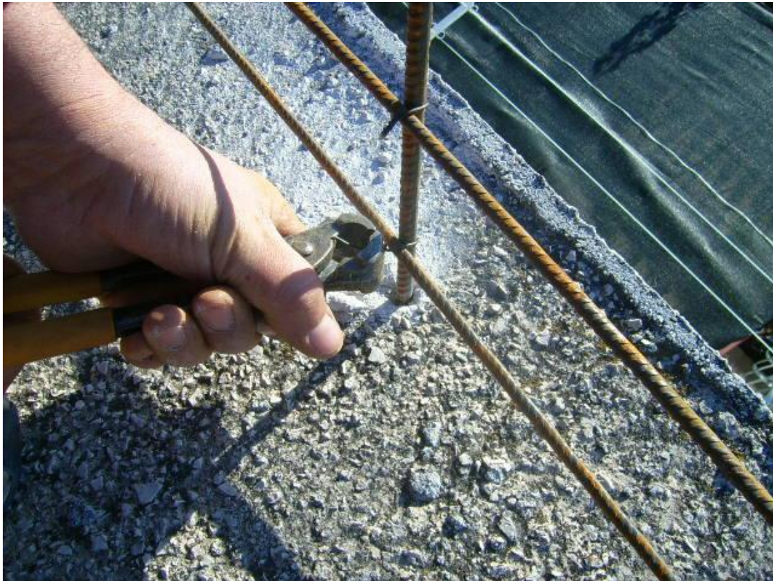
Slika 7. Izrada željeznog skeleta betonskog zida
