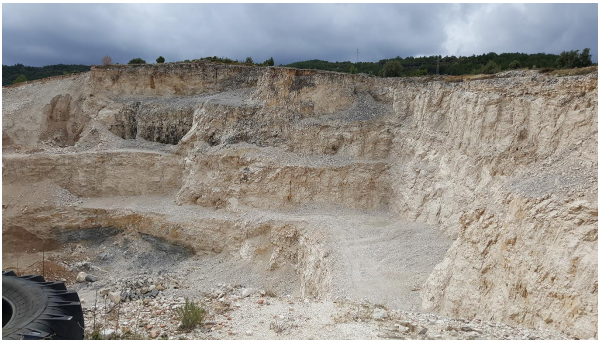
Slika 6: Pogled na kamenolom Nerežišća.
