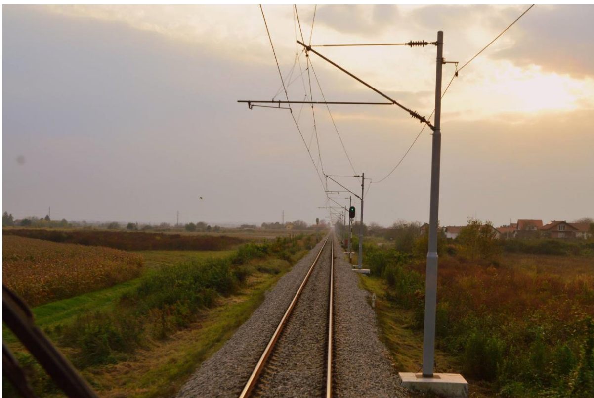
Sl. 10. Dionica pruge Zagreb – Karlovac Izvor: Danijel Obradović 25.5.2016.
