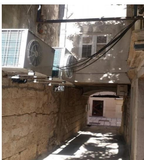
Sl. 20. Primjer neadekvatno postavljenih vanjskih jedinica klima uređaja i kablova
