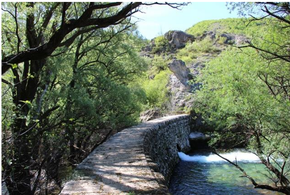
Slika 4. Brana na rijeci Zrmanji nizvodno od izvora (foto. S. Gottstein).
