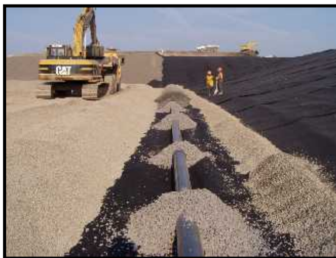
Slika 3. Prikaz izgradnje drenažnog sloja sa perforiranom cijevi
