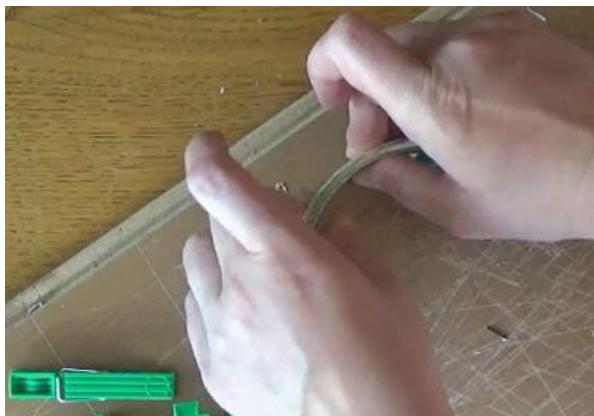
Slika 2.13. Lijepljenje zrcala dvokomponentnim ljepilom.
