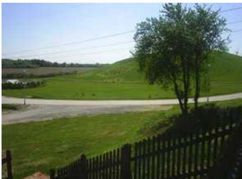
Slika 4. Sanirano odlagalište otpada „Mraclinska dubrava“ ( http://www.mzopu.hr )
