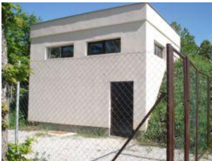
Slika 5. Vodosprema lokalnog vodovoda (Foto: Martina Kurečić)
