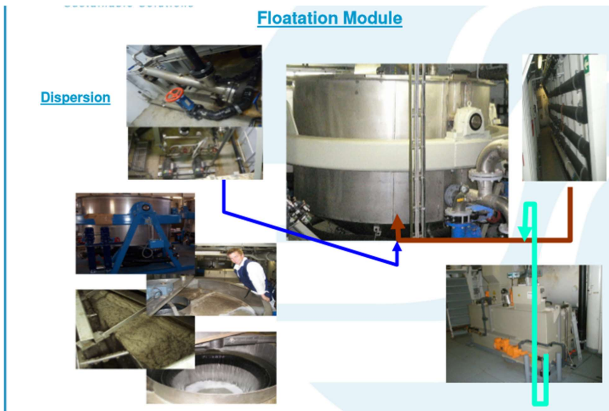
Slika 6.10. Proces flotacije na primjeru broda Adventure of the Seas ; preuzeto iz interne prezentacije „ Scanship AWP – Adventure of the Seas “
