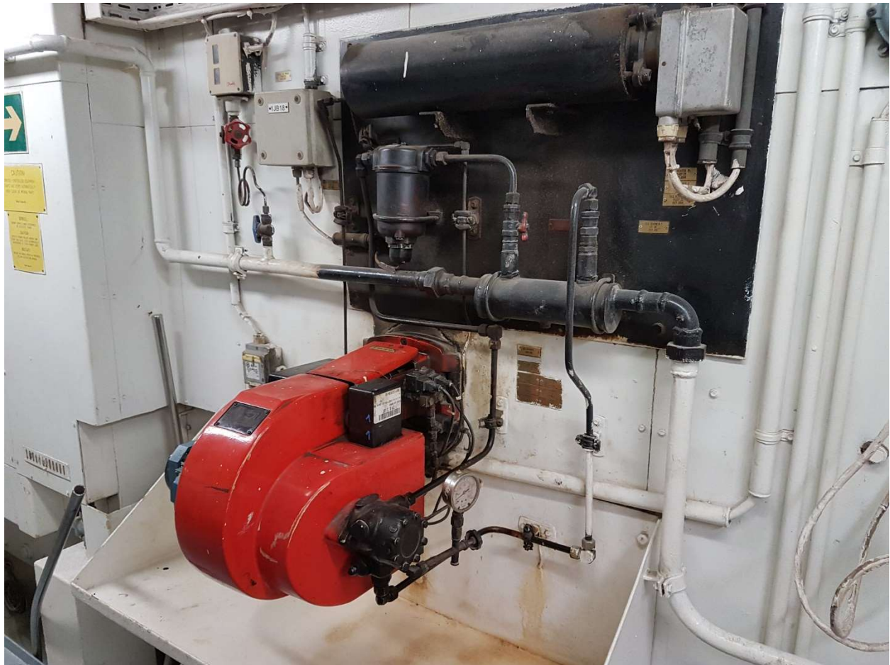
Slika 4.5. Sekundarna spalionica; fotografija: Nikola Marvučić
