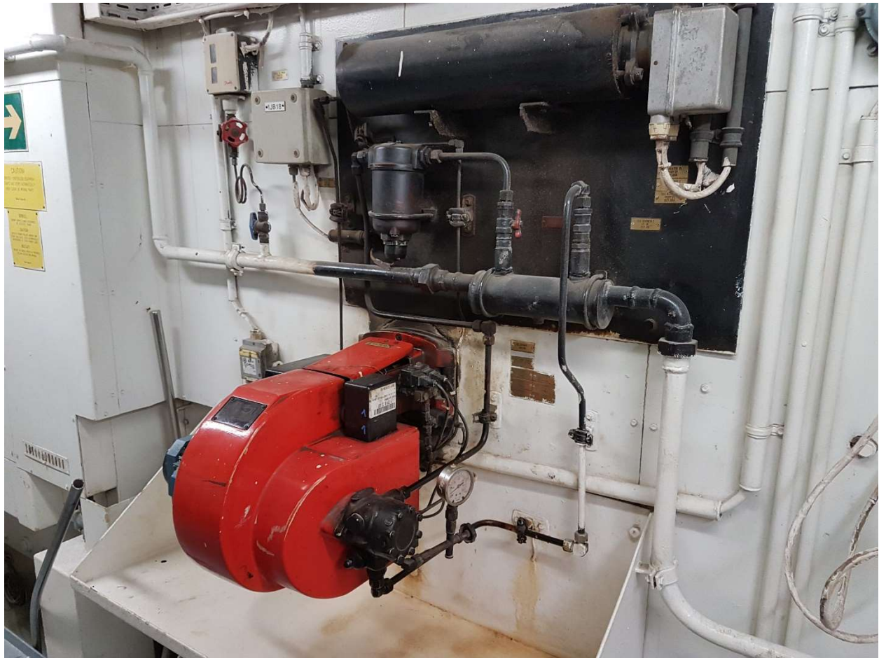
Slika 4.5. Sekundarna spalionica; fotografija: Nikola Marvučić
