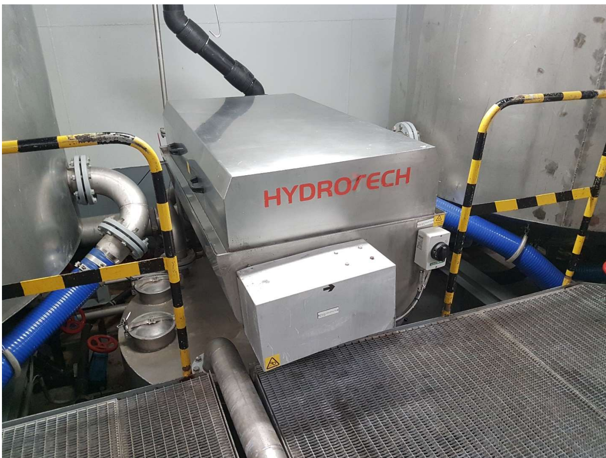
Slika 6.11. Filter za poliranje; fotografija: Nikola Marvučić
