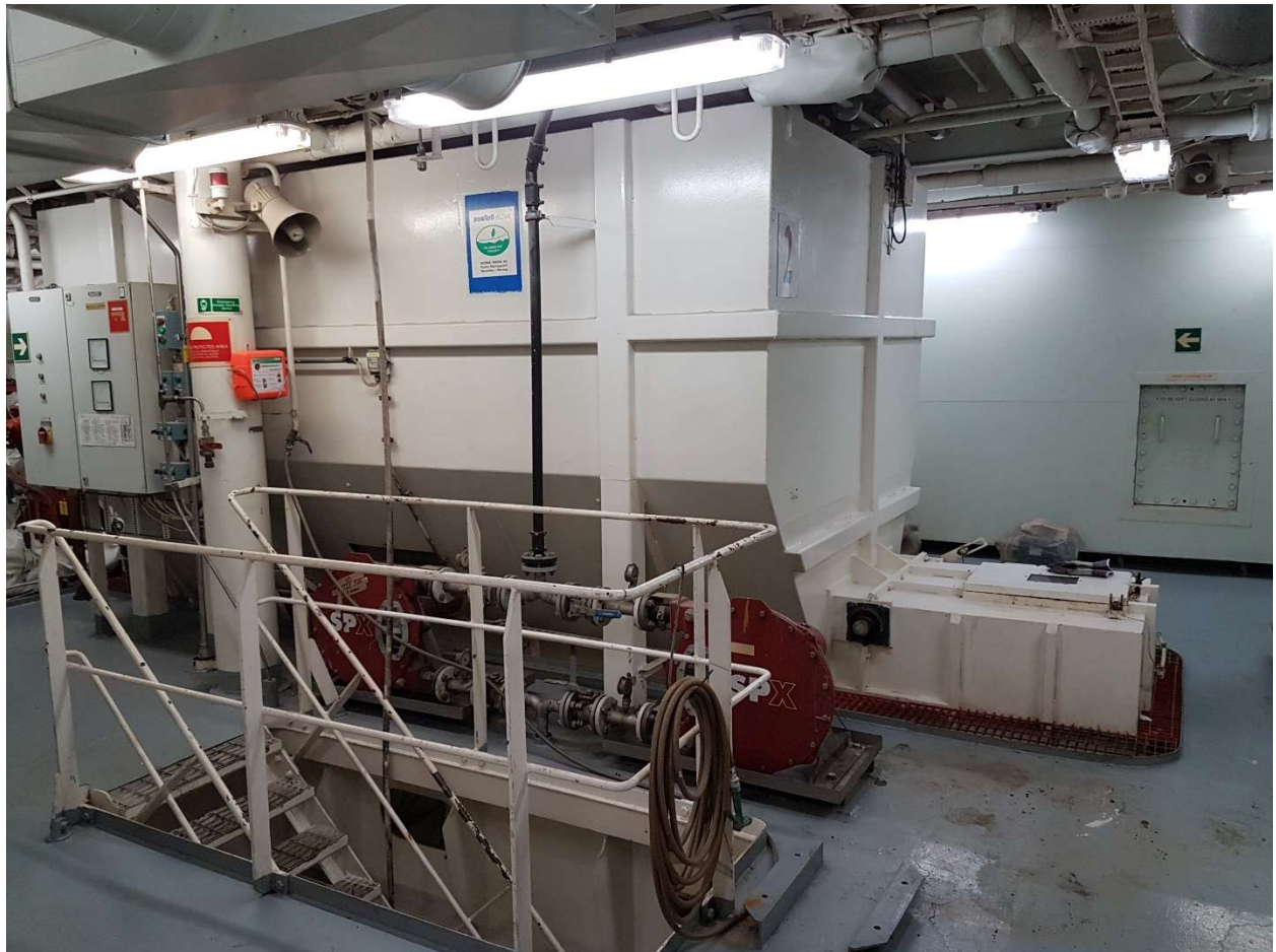
Slika 4.2. Kontejner za prihvati usitnjene odpadke; fotografija: Nikola Marvučić
