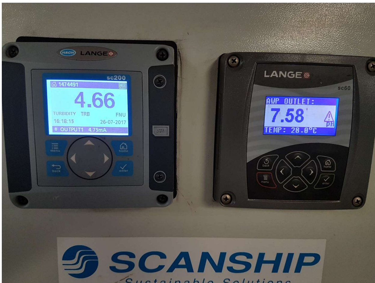
Slika 6.14. Instrumenti za mjerenje pH i TSS; fotografija: Nikola Marvučić
