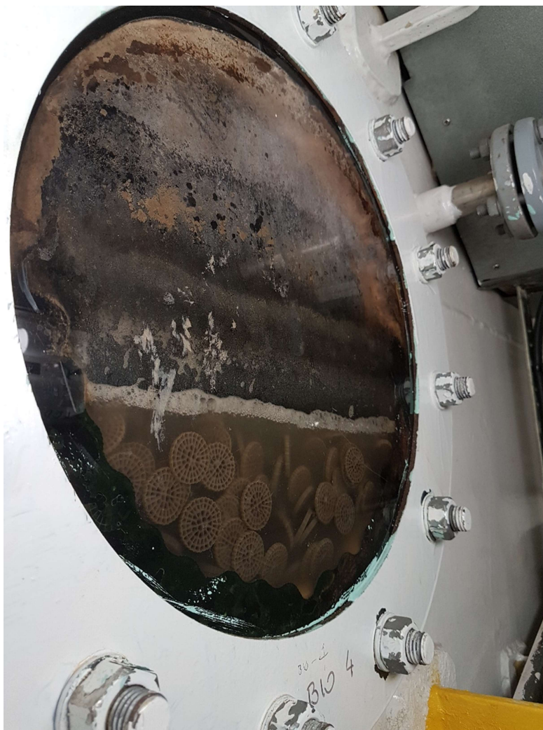
Slika 6.6. Plastični filmovi s bakterijama unutar bio - spremnika; fotografija: Nikola Marvučić
