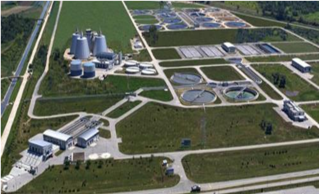
Slika 8. Uređaj za pročišćavanje otpadnih voda grada Zagreba, odakle su uzeti otpadna voda, aktivni mulj i tlo (izvor: www.epirh.com )
