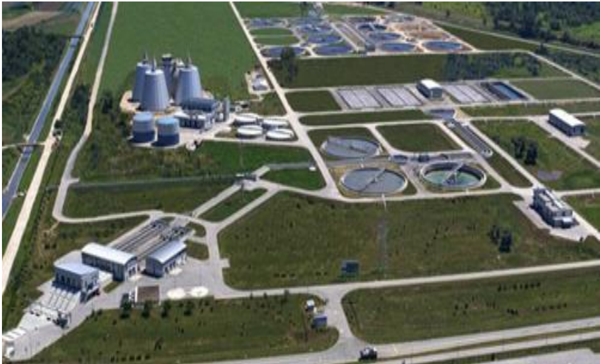
Slika 8. Uređaj za pročišćavanje otpadnih voda grada Zagreba, odakle su uzeti otpadna voda, aktivni mulj i tlo (izvor: www.epirh.com )
