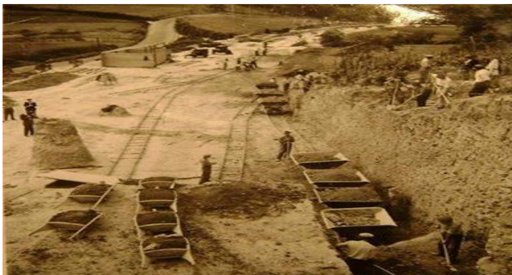
Sl. 33. Izgradnja tunela „Sljeme“ u Gračanima 1947. godine
