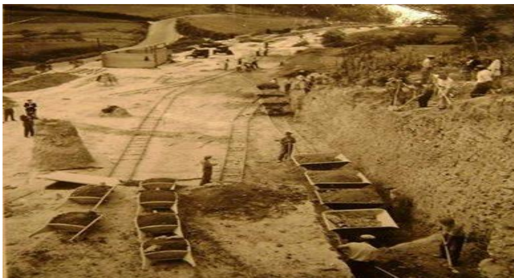
Sl. 33. Izgradnja tunela „Sljeme“ u Gračanima 1947. godine
